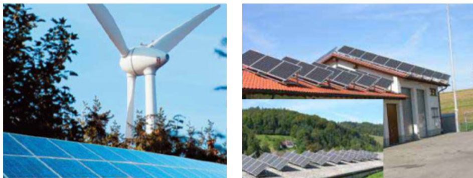
Windenergie- und Solarstromanlagen in Freiamt. Quelle: RegioRegenerativ.
