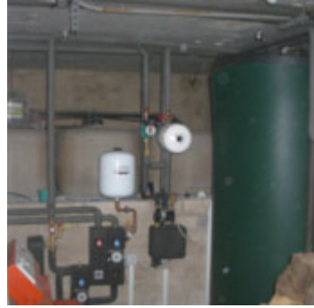
Solar – na klar! Solarstromanlagen; Blick in die Heizzentrale mit 750 Liter-Wärmespeicher.
