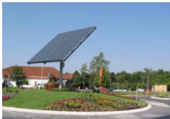
Von Eberhard Renz in Bürstadt initiierte Solarstromanlagen: 5 kWp-Sonnensegel und 5 MWp-Solardach. Quellen: Eberhard Renz, Tauber Solar.
