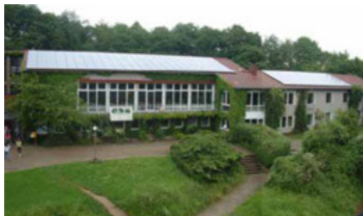
30,6 kW Bürgerstromanlage auf dem Dach der Jugendbildungsstätte Berchum; PV-Anlage als Solarmarkise an der Grundschule. Fotos. Helmuth Küffner und Karl-Friedrich Winterhager.
