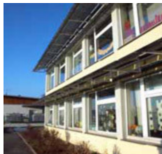
30,6 kW Bürgerstromanlage auf dem Dach der Jugendbildungsstätte Berchum; PV-Anlage als Solarmarkise an der Grundschule. Fotos. Helmuth Küffner und Karl-Friedrich Winterhager.
