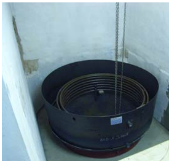
Tiefer gelegt: Ein großer Solarspeicher ersetzt den Öltank. Fotos: Klaus Schmitt
