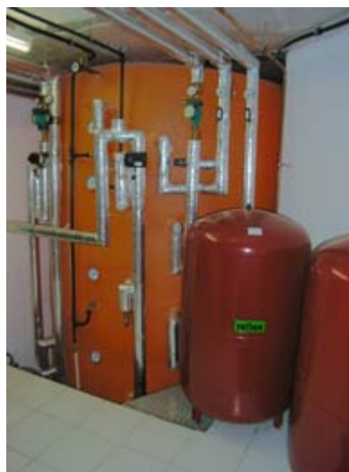
Tiefer gelegt: Ein großer Solarspeicher ersetzt den Öltank. Fotos: Klaus Schmitt
