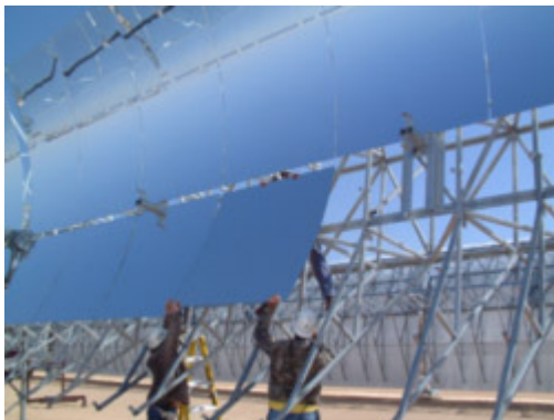
Zupacken für den Strom aus der Wüste. Montage der Spiegel für eine Demo-Parabolrinnenanlage, Montage der Absorberrohre. Quelle: Solar Millennium AG
