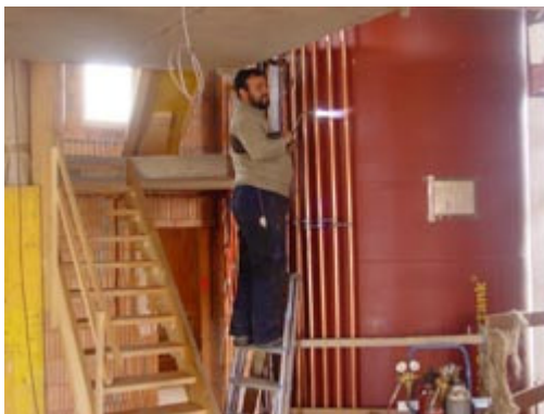
Verrohrung des Pufferspeichers (links); Speicher. Fotos: Zukunft Sonne
