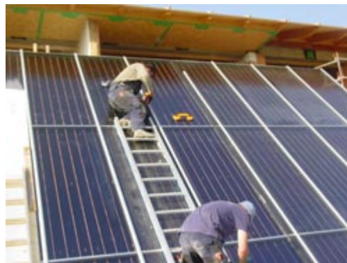
Photovoltaik-Module auf dem Dach (links) und solarthermische Kollektoren an der Schrägfassade (rechts bzw. links vorne). Fotos: Zukunft Sonne
