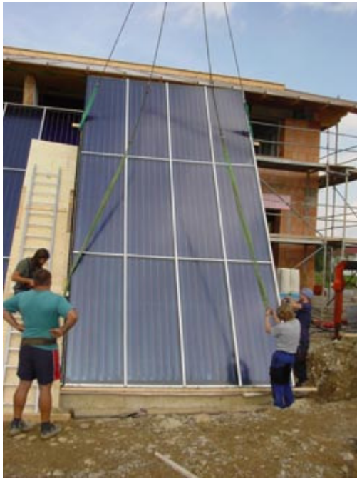
Montage der Fassadenkollektoren und des Solar-Speichers. Fotos: Zukunft Sonne
