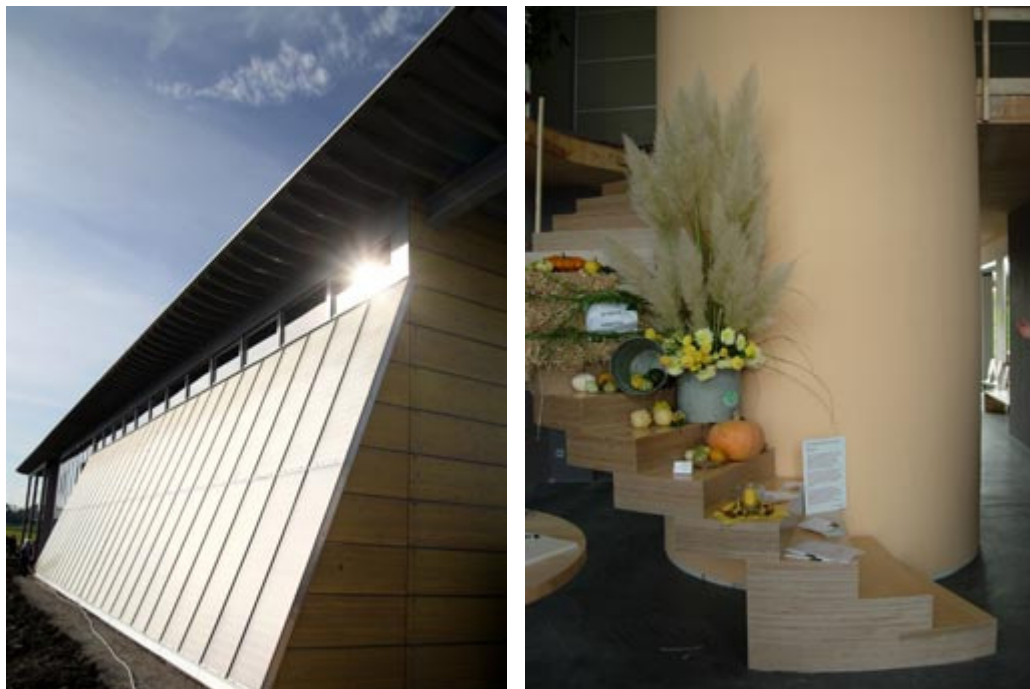
Kollektorfassade und Solarspeicher des Sonnenzentrums in Rottenburg. Fotos: Hartmann Energietechnik GmbH
