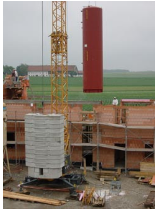
Montage der Fassadenkollektoren und des Solar-Speichers. Fotos: Zukunft Sonne
