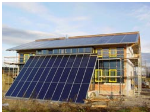
Photovoltaik-Module auf dem Dach (links) und solarthermische Kollektoren an der Schrägfassade (rechts bzw. links vorne). Fotos: Zukunft Sonne
