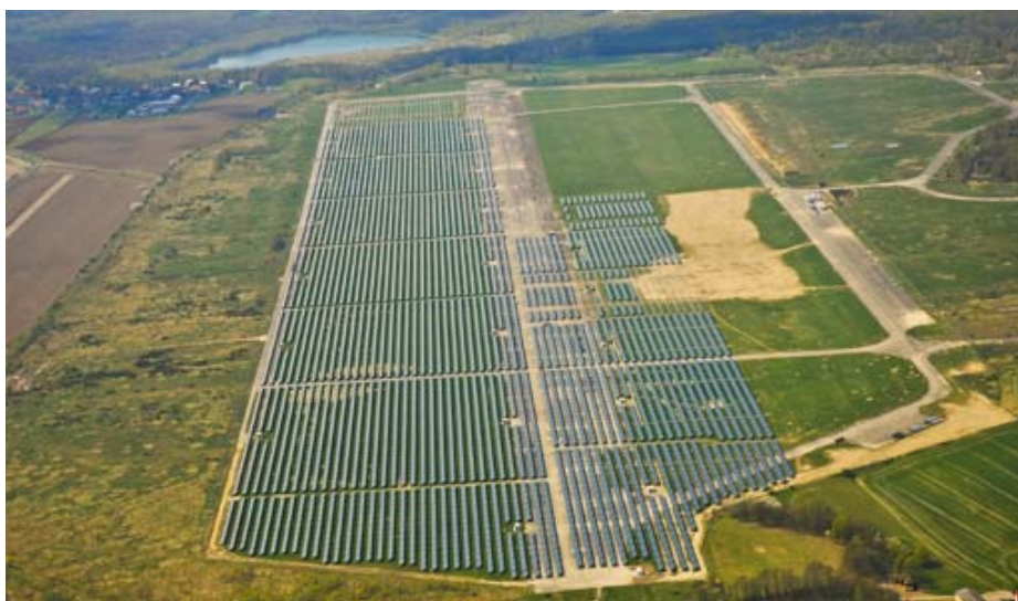
Solar-Kraftwerk "Energiepark Waldpolenz": Ab 2009 werden pro Jahr rund 40 Millionen Kilowattstunden Solarstrom erzeugt. Foto: juwi-Gruppe.
