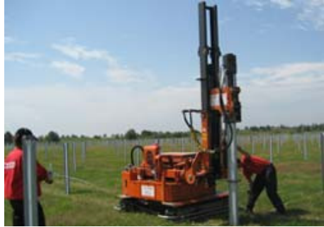
Links: Rammen der Pfosten. Rechts: Modultische aus Aluminium.
