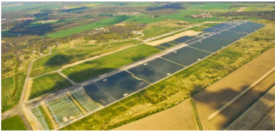
Baufortschritt des Energieparks "Waldpolenz" Ende Mai 2008.
