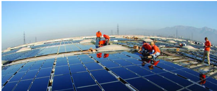
Dünnschicht für US-Dächer: Vor allem in Kalifornien entstehen derzeit überall Photovoltaik-Kraftwerke. Auf diesem Dach in Fontana werden zwei Megawatt First Solar-Module verbaut.
