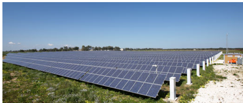
Photovoltaik-Freiflächenanlage mit 24.600 Modulen vom Typ Evergreen Solar ES-A in San Vito dei Normanni bei Brindisi. Foto: Evergreen Solar Inc.
