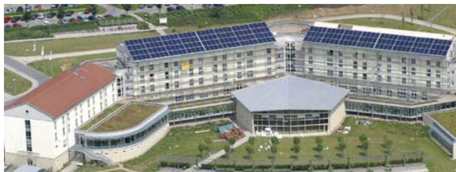
Rehaklinik Bad Frankenhausen: 646 Quadratmeter Kollektorfläche (32 Großkollektoren) auf zwei Dächern. Foto: BINE Informationsdienst
