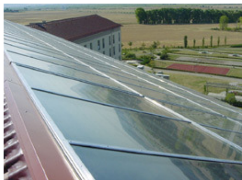
Solarthermie-Goßkollektoren; Details. Fotos: BINE Informationsdienst
