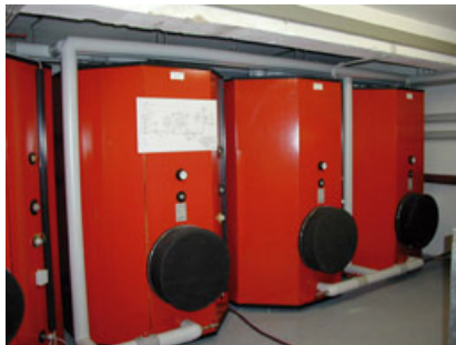
Links: Pufferspeicher der Solaranlage des Studentendorfs Freiburg Vauban. Rechts: Externer Wärmetauscher. Fotos: Hochschule Offenburg.
