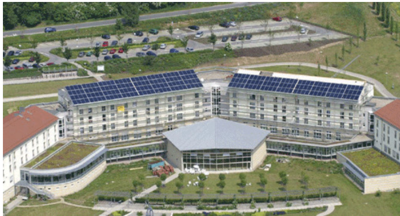
Solarwärmeanlage der Rehaklinik Bad Frankenhausen. Quelle: Xtoday-Media Verlag; TU Ilmenau
