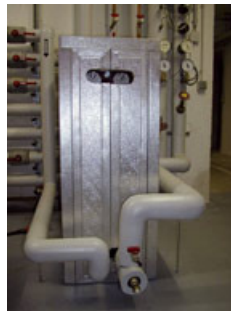
Links: Pufferspeicher der Solaranlage des Studentendorfs Freiburg Vauban. Rechts: Externer Wärmetauscher. Fotos: Hochschule Offenburg.
