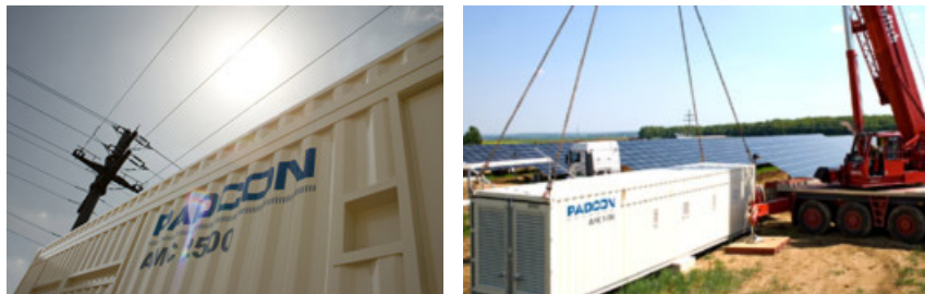
Megawatt-Wechselrichter "PADCON AMC 2500C" (links); Vorgänger "AMC1600" im Referenzkraftwerk (1,75 MWp)
