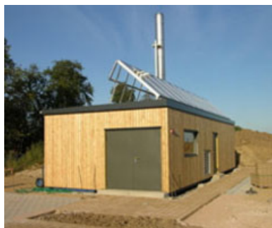
Die Energiekabine liefert Wärme aus Solarthermie-Kollektoren, Holzpellets und Holz hackschnitzeln. Rechts: Holzpellet-Lieferung
