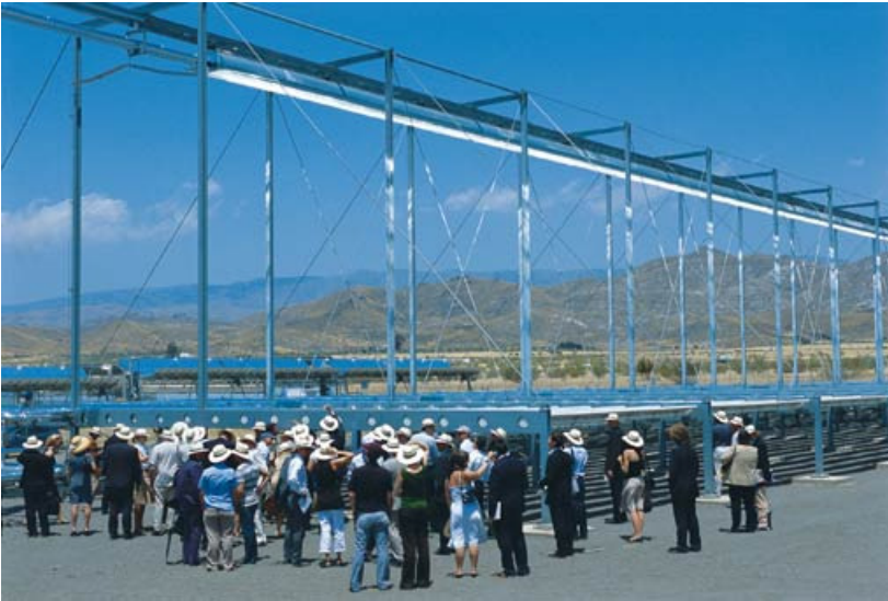
Einweihung des Fresnel-Kollektorfeldes auf der Plataforma Solar de Almería. Foto: MAN Ferrostaal AG; de Riese
