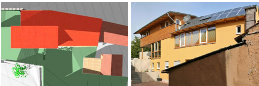
Links: Mit einem CAD-Modell wurde eine Verschattungsstudie durchgeführt, um die Solarenergie sowohl passiv (Ausrichtung der Fenster) als auch aktiv optimal zu nutzen (Orientierung der Solarmodule); Rechts: Teilansicht des Solargenerators.
