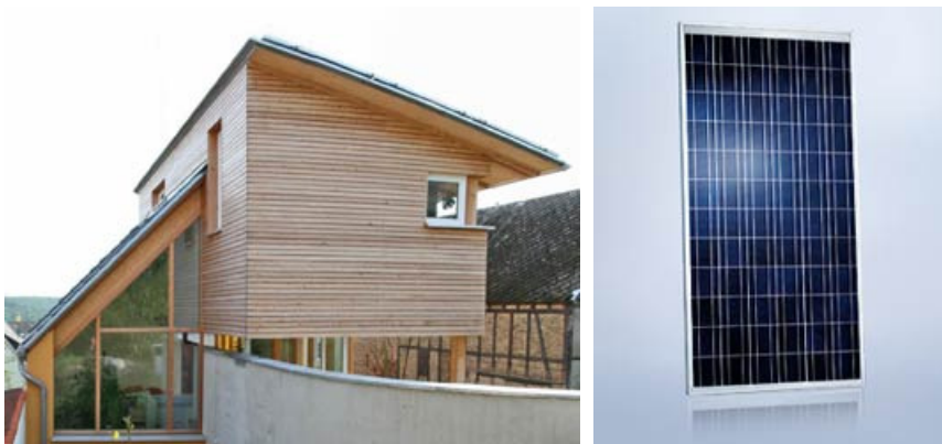
Blick aus dem Garten auf das Gebäude: Auf dem 19° geneigten Hauptdach sind 36 Solarmodule von SCHOTT Solar installiert. Quellen: C. Dahl; SCHOTT Solar AG.
