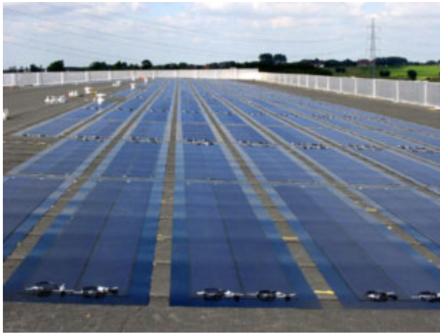
PV-Dach mit Biohaus- Dünnschichtmodulen. Quelle; Biohaus
