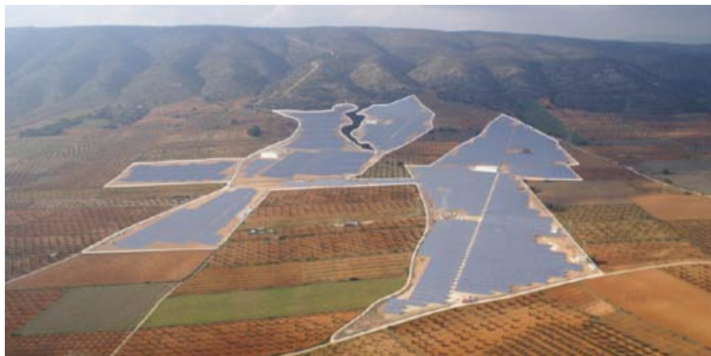
Mit dem Solarpark Beneixama (20 MW) führt die City-Solar-Gruppe die aktuelle Photovoltaik-Weltrangliste an. Foto: City Solar AG
