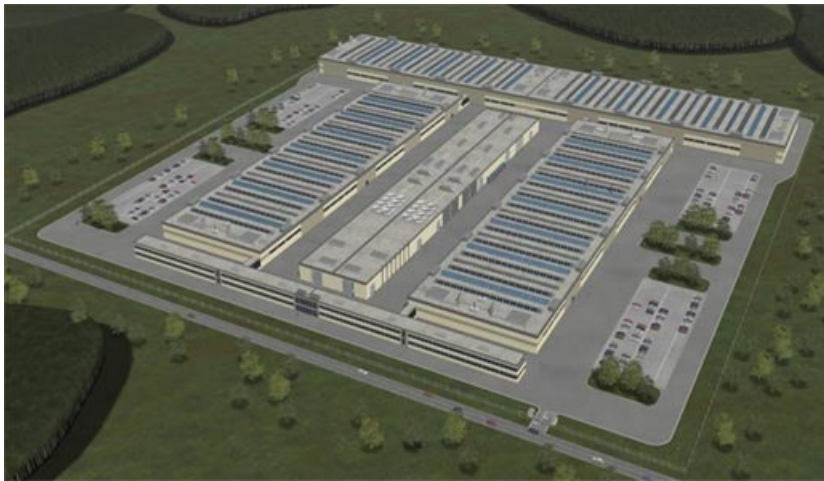
Entwurf einer Gigawatt-Photovoltaikfabrik mit zwei Produktionseinheiten à 450 MW und zentralen, gemeinsamen Versorgungssystemen. Grafik: M+W Zander FE GmbH
