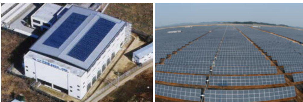
Links: 70 kW-PV-Dach in Yachiyo City (Japan). Rechts: 19,6 MW Photovoltaik-Kraftwerk in SinAn (Südkorea). Quellen: Evergreen Solar, Inc. Conergy AG.
