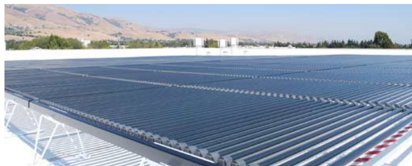
Röhre an Röhre: Solyndra-Paneele sollen große Dachflächen bedecken. Quelle: Solyndra Inc
