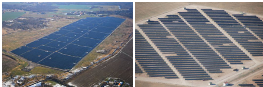
Links: PV-Kraftwerk mit Modulen aus Cadmiumtellurid (CdTe) in Waldpolenz, Deutschland. Rechts: Anlage mit CIS-Modulen in Albacete, Spanien. Fotos: juwi Gruppe (l.) und Würth Solar (r.)
