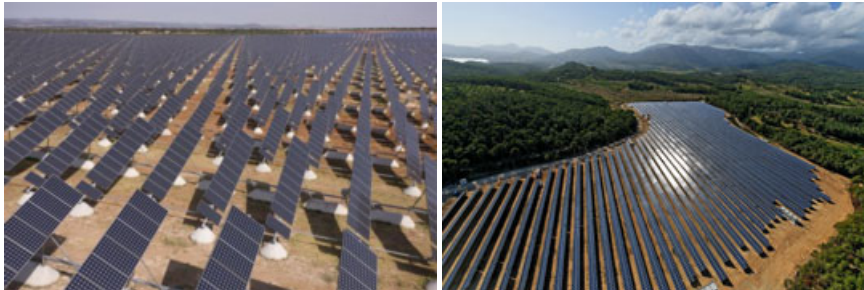
Links: Solarpark Olivenza in Spanien. Foto: SunPower Corp. Rechts: Solarpark in Calvià vor der Serra de Tramuntana (Mallorca). Foto: MPC Capital Gruppe; MPC Capital AG
