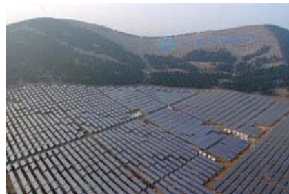
Foto: Das Solar-Kraftwerk Xunzhou erstreckt sich auf 400.000 Quadratmetern Hügelland nahe der Stadt Xuzhou in der chinesischen Provinz Jiangsu. Das Photovoltaik-Kraftwerk mit einer Nennleistung von 20 MW soll jährlich rund 26.000.000 Kilowattstunden (kWh) Solarstrom produzieren. Laut Satcon handelt es sich hierbei um das aktuell größte Solar-Kraftwerk Chinas. Quelle: Satcon Technology Corporation
