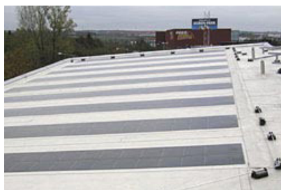
Photovoltaikanlagen auf der Basis von Unisolar-Laminaten. Quelle: Centrosolar AG
