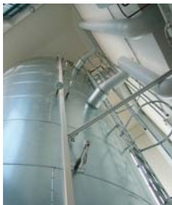
Montage des 100 Kubikmeter großen Solar- und Pufferspeichers; Speicher im ehemaligen Kesselhaus. Fotos: EGS-plan, Stuttgart.
