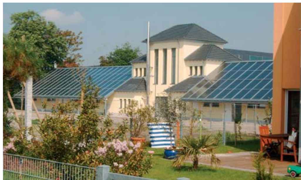
Ansicht des ersten Solar-Kollektorfeldes im Zentrum des neuen Wohngebiets am „Alten Schlachthof“ in Speyer. In die Wärmeversorgung wurde eine Solaranlage mit Mehrtagespeicher integriert. Foto: ZfS – Rationelle Energietechnik GmbH, Hilden
