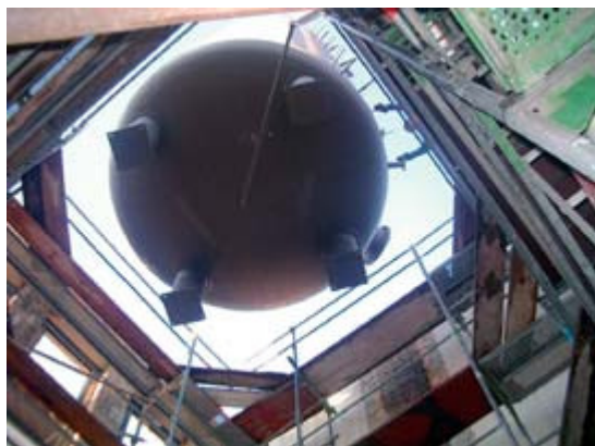
Montage des 100 Kubikmeter großen Solar- und Pufferspeichers; Speicher im ehemaligen Kesselhaus. Fotos: EGS-plan, Stuttgart.
