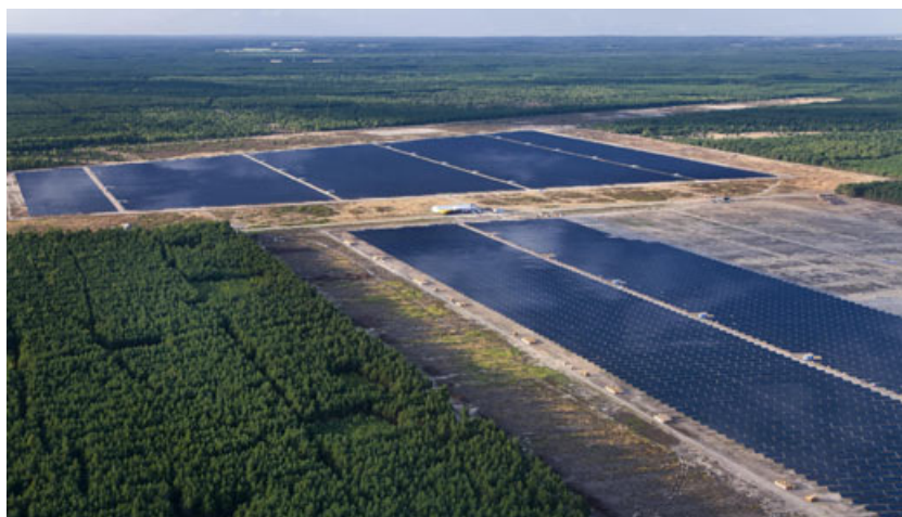
Solarstrom-Produktion im Kraftwerksmaßstab: Solar-Kraftwerk "Lieberose" in Brandenburg. Quelle: juwi-Gruppe
