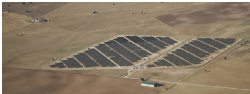
3,26 Megawatt-Solarkraftwerk in Albacete, Spanien.
