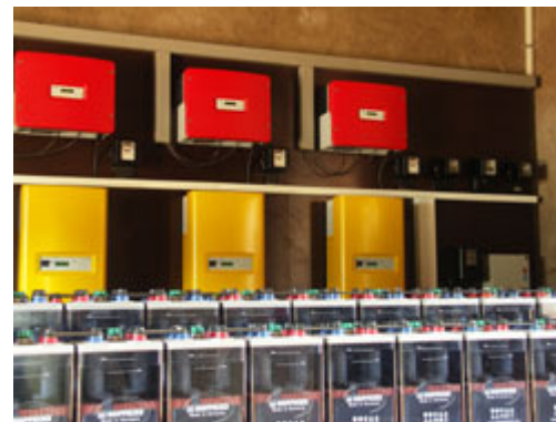
Solarstromanlage auf dem Kirchendach in Mbinga (Tansania); Solarmodule, Wechselrichter und Batterien sorgen für sichere Energieversorgung fern vom Stromnetz. Fotos: Energiebau Solarstromsysteme GmbH
