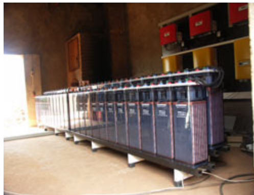
Generatorsteuerung (links im Vordergrund). Etwa zwei Dutzend Batterien gewährleisten die Stromversorgung rund um die Uhr. Fotos: Energiebau Solarstromsysteme GmbH
