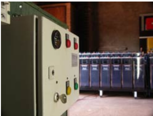
Generatorsteuerung (links im Vordergrund). Etwa zwei Dutzend Batterien gewährleisten die Stromversorgung rund um die Uhr. Fotos: Energiebau Solarstromsysteme GmbH
