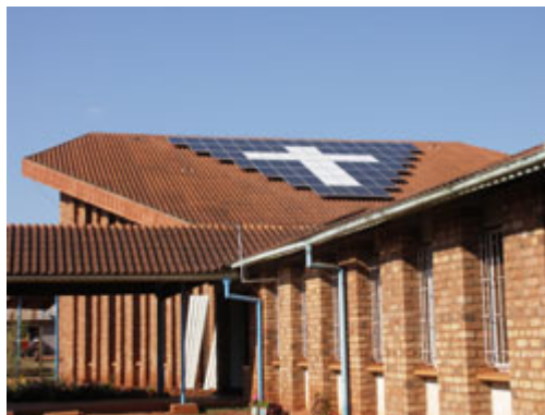
Solarstromanlage auf dem Kirchendach in Mbinga (Tansania); Solarmodule, Wechselrichter und Batterien sorgen für sichere Energieversorgung fern vom Stromnetz. Fotos: Energiebau Solarstromsysteme GmbH
