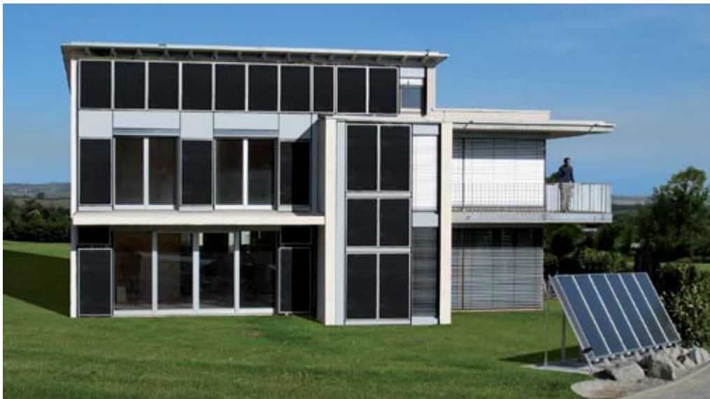
Foto: Doppelhaus mit zwei SOLAERA-Anlagen und Kollektoren im Garten und an der Fassade. Quelle: Consolar Solare Energiesysteme GmbH
