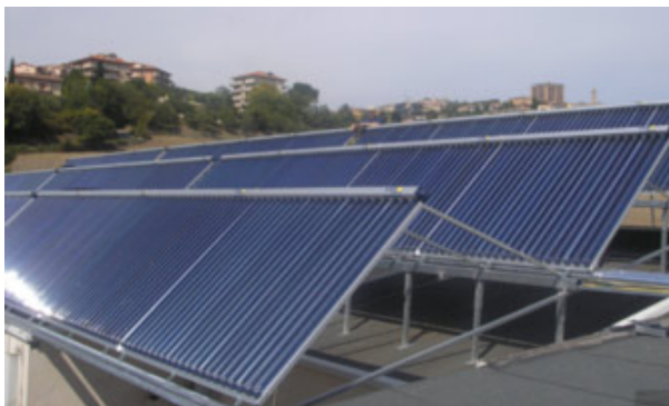
Links: SGA eines mehrgeschossigen Wohnhochhauses bei Katowice (Polen). Rechts: CPC-Kollektoren eines Hallen- und Freibades in Ancona (Italien). (Fotos: Paradigma Energie- und Umwelttechnik GmbH & Co. KG.
