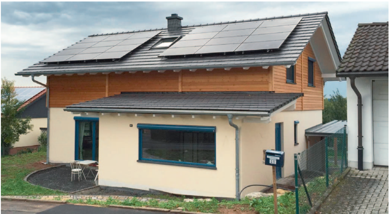
Plusenergiehaus dank PVT-Kollektoren und einem Speicher im Erdreich.
