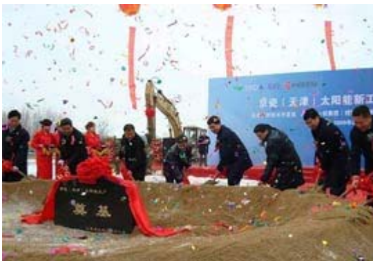
Foto: Erster Spatenstich für eine Kyocera-Fabrik in China.
