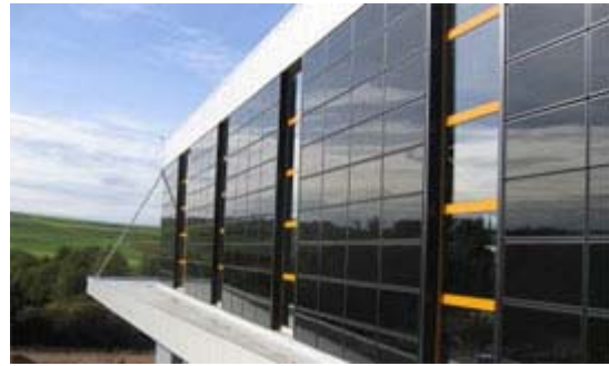
Photovoltaik-Fassade mit CIS-Modulen von Sulfurcell (Foto: Sulfurcell)
