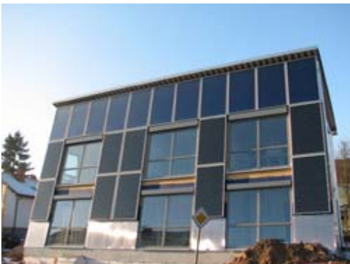
Solar-Fassade mit 11 thermischen Solarkollektoren und 10 Photovoltaikmodulen. Foto: das baustudio
