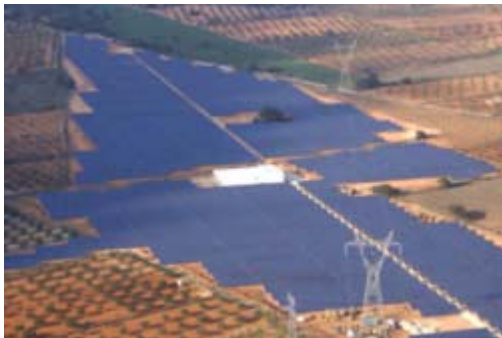
Photovoltaik-Kraftwerk im spanischen Beneixama. Quelle: City Solar AG
