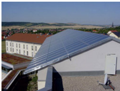
Links: Solarthermie-Kombianlage zur Warmwasserbereitung und Heizungsunterstützung. Rechts: Solarthermische Kollektoren für Prozesswärmeanwendungen
