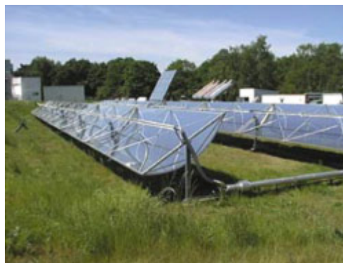
Links: Solarthermie-Kombianlage zur Warmwasserbereitung und Heizungsunterstützung. Rechts: Solarthermische Kollektoren für Prozesswärmeanwendungen
