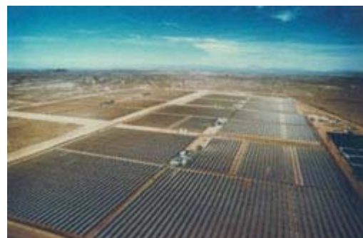
Solarkraftwerk bei Kramer Junction (USA): Über 2 Millionen Quadratmeter Parabolrinnenkollektoren mit einer Stromerzeugungskapazität von 354 Megawatt. Quellen: Forschungsverbund Sonnenenergie; DLR.
