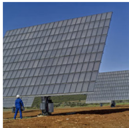
Rechts: FLATCON-Module auf Abengoa-Trackern in Puertollano. Fotos: Fraunhofer ISE; Concentrix Solar GmbH.
