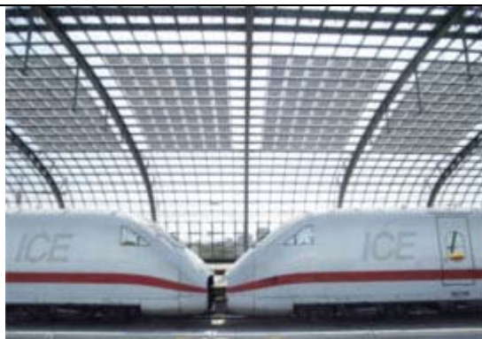
2 Mal High-tech aus Deutschland: Photovoltaikanlage auf dem Dach des Lehrter Bahnhofs in Berlin, ICE der Deutschen Bahn. Foto: BSW-Solar/Langrock
