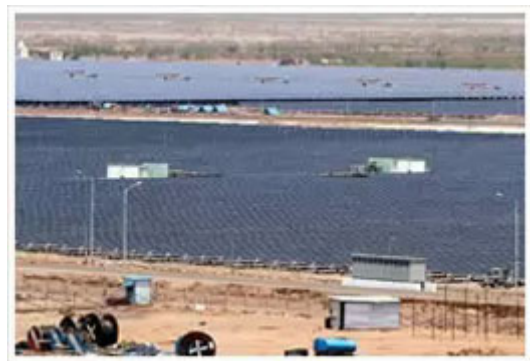
Teilansicht des Gujarat-Solarparks, der im Endausbau eine Gesamtleistung von 600 MW erreichen soll.
