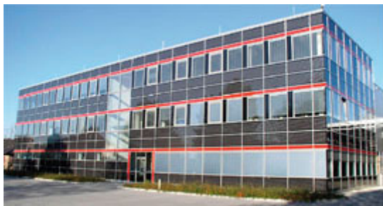
Photovoltaik-Fassade eines Industriegebäudes. Quelle: Burchard Decker
